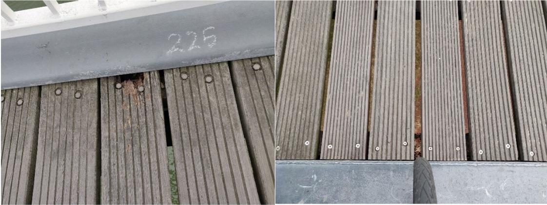
Die Spaltmaße sind zu groß und im Kopfbereich längs zur Fahrtrichtung ausgerichtet:
